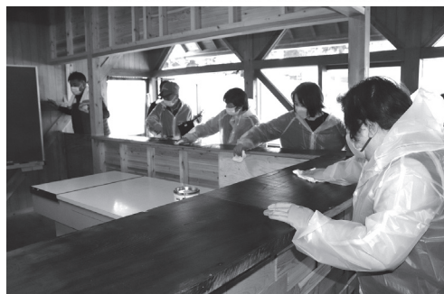
【古材をカウンターにするための塗装作業】
