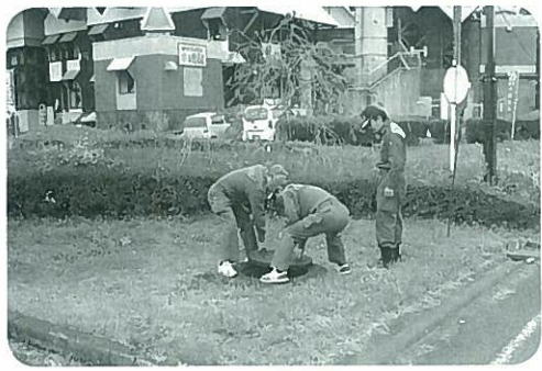
防火水槽点検
