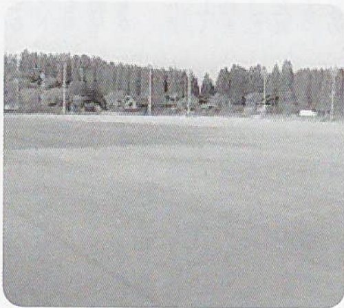
改修される町営グラウンド「林間広場」
