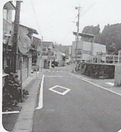
完了した町道倉原松原線舗装工事
