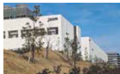
台湾から日本に進出した半導体工場
