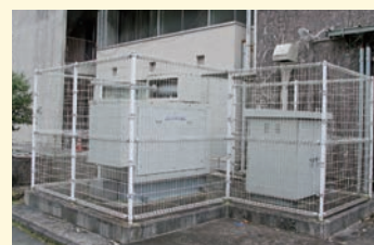
移設する自家発電機
