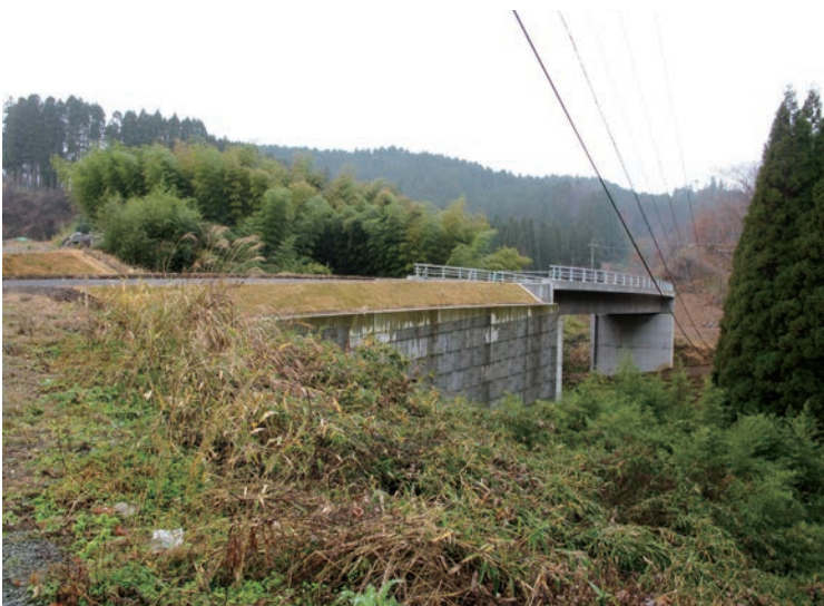
建設中の西里明里線
