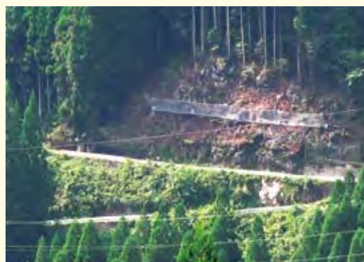
北河内線災害復旧工事
