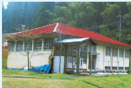
解体される中学校武道場
