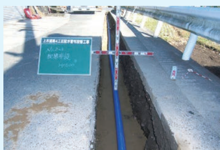
上水道管布設替工事
