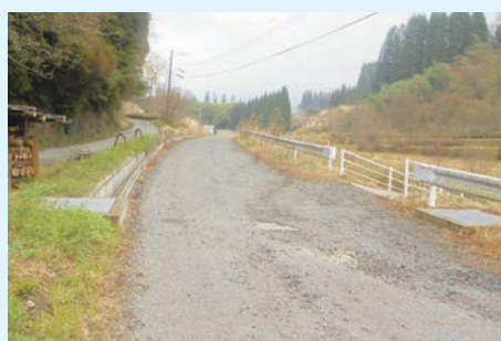
新設工事が進む明里線
