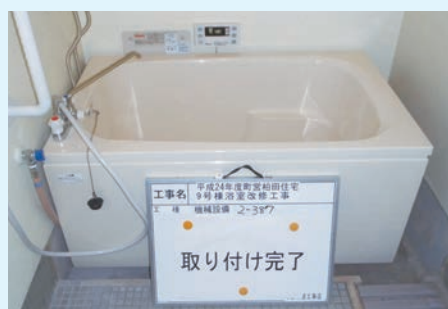
真新しい浴槽になった浴室
