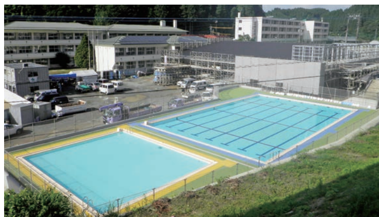
小国小・中学校工事
