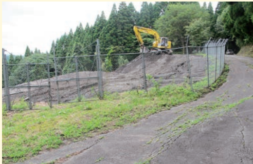
城村最終処分場
