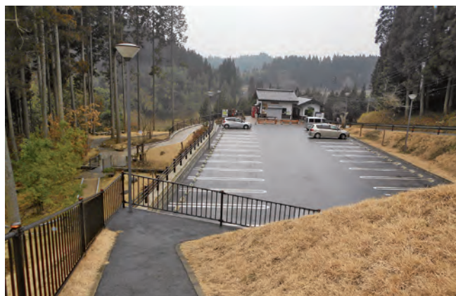
鍋ヶ滝駐車場
