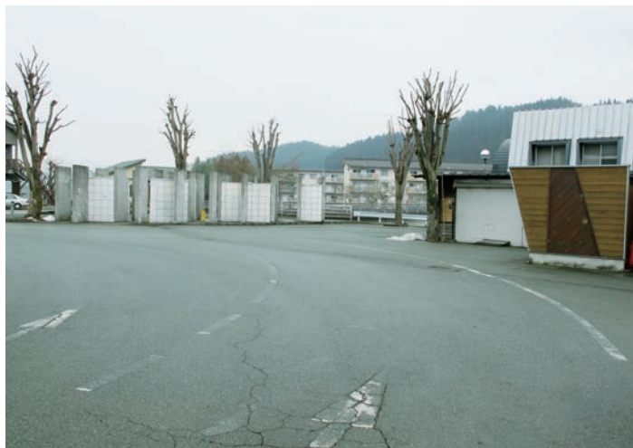
ゆうステーショントイレ
