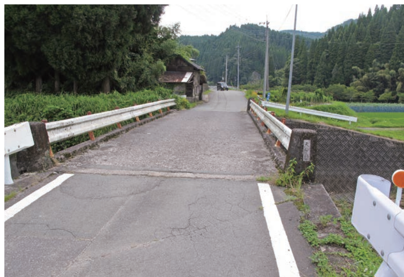
下滴水線の天神橋
