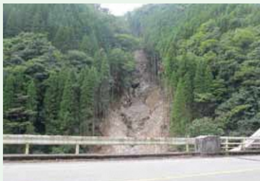
国道212号線沿い杖立地区
