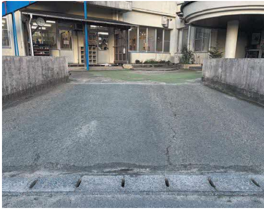
修繕予定の宮原保育園のスロープ
