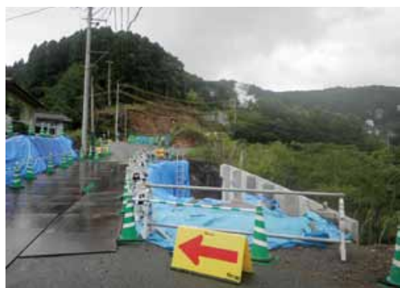
町道はげの湯線道路改良工事
