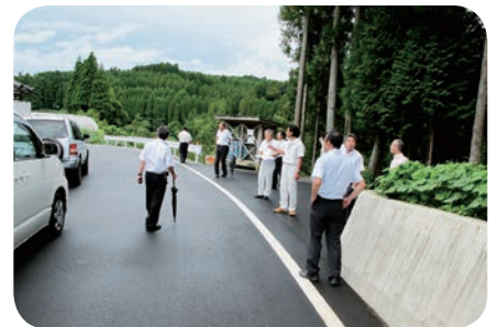
小原田寺尾野線道路改良工事
