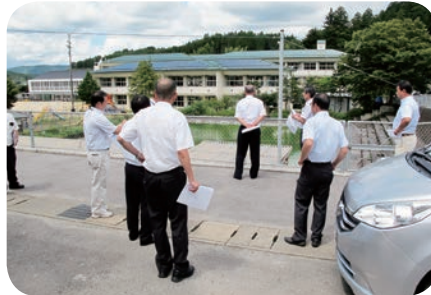
小国小太陽光発電設備
